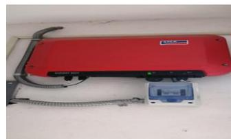
Fig. 11. Regulador de carga para paneles solares con banco de baterías
